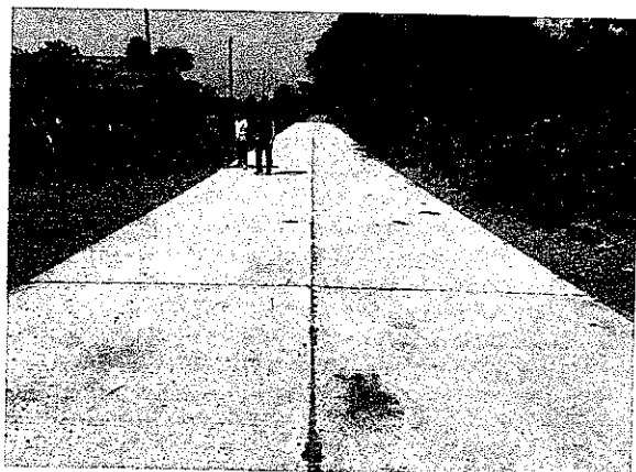
๗.๖ โครงการก่อสร้างถนนคอนกรีตเสริมเหล็ก ถนนตะวันรอน หมู่ที่ ๕ บ้านหนองบัวทอง
